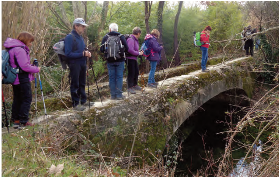
Pont romain de Lecques
