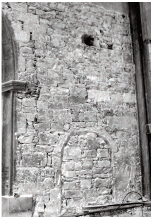
Fig. 19 - Détail de la porte 1052 située entre le chœur et la sacristie à l'extrémité nord orientale de l'église. Bâtie en même temps que le pan de mur, au XVII e s. et bouchée tardivement.
